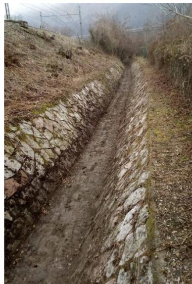
**Figura 5 a destra, canale a lato della ferrovia a Fondotoce, fase di pulizia del primo tratto.**
