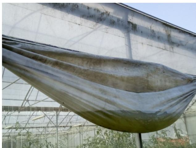
**Figura 5, un accumulo di acqua in una telo di copertura di una serra.**
