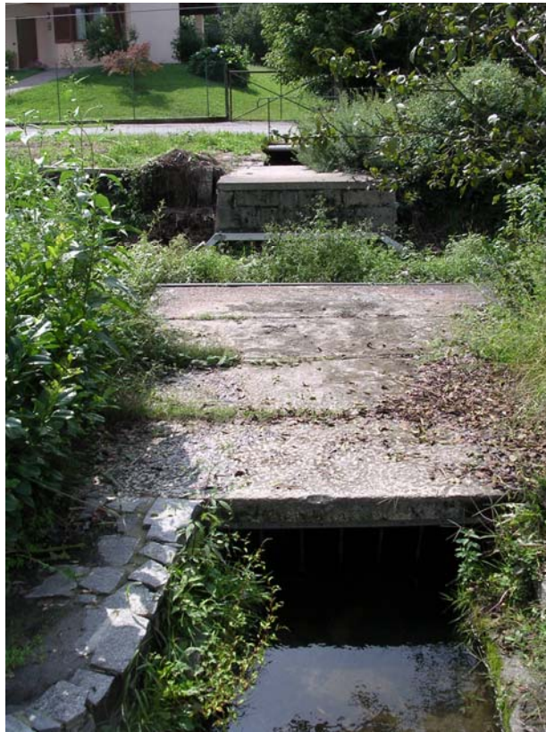
Particolare del sifone sulla Roggia dell'Olearo, presso l'attraversamento FS
