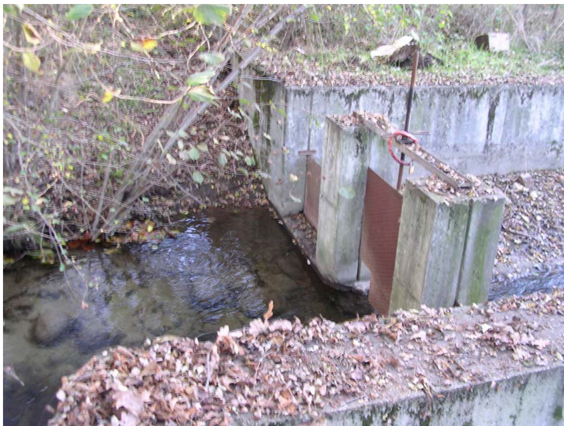
Foto 2 – chiuse di derivazione della Roggia dell'Oleario o dello Scolatore
