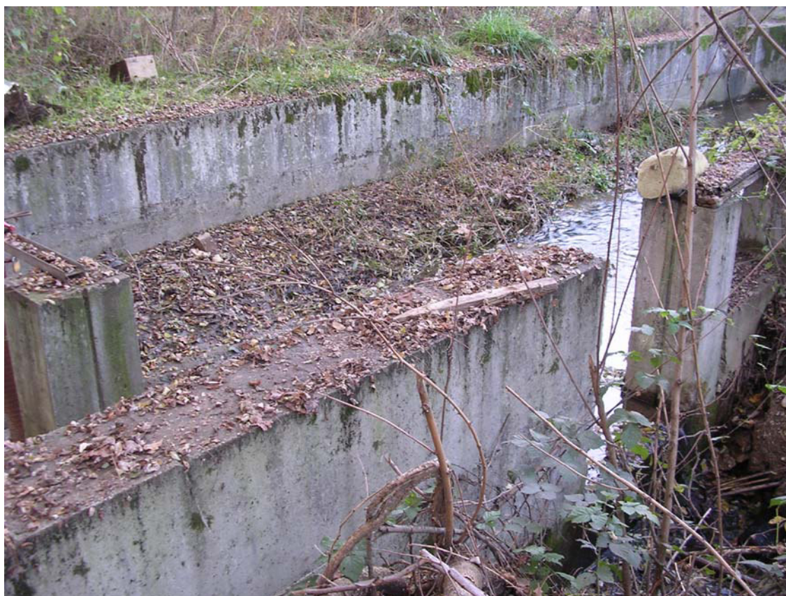
Foto 3 – bocca di derivazione del Rio Scolatore (a destra) e vasca di laminazione
