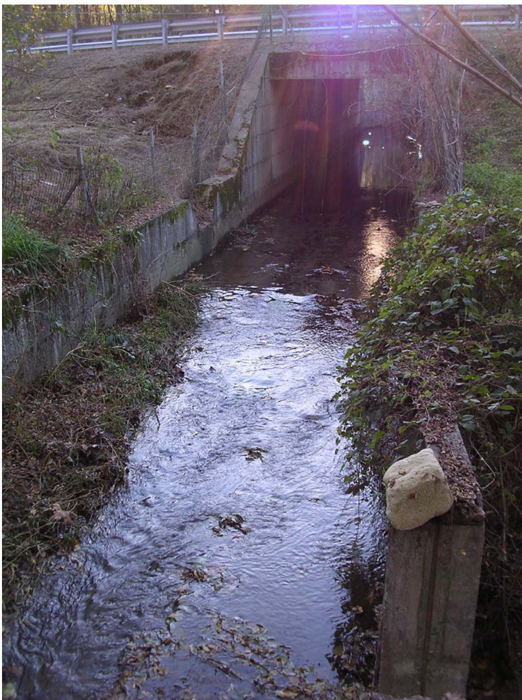
Foto 1 – manufatto di derivazione della Roggia dell'Olearo o dello Scolatore e sottopasso svincolo autostradale
