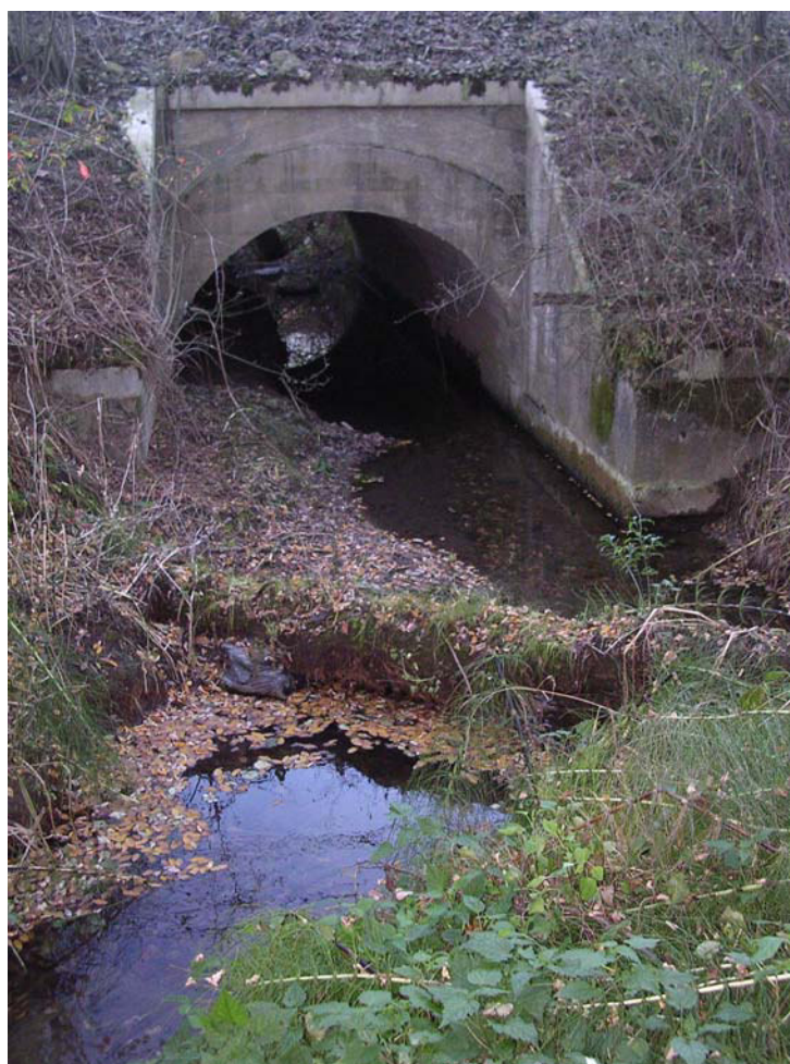
Foto 5 –sottopasso ferroviario della roggia irrigua derivata dal Torrente Norè
