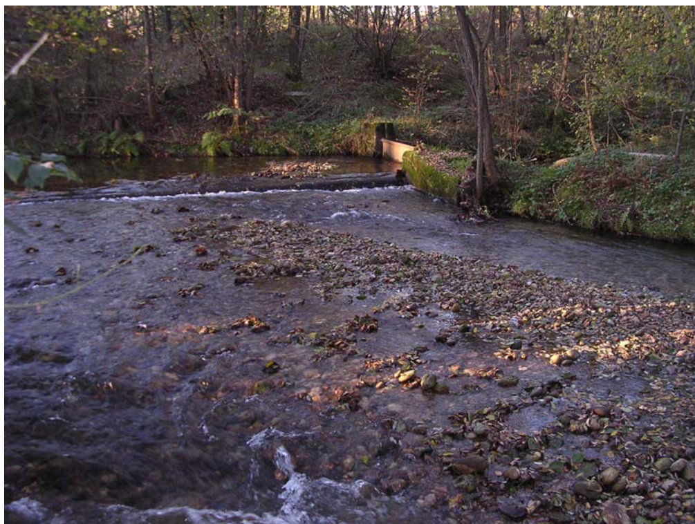
Foto 4 –derivazione di roggia irrigua dal Torrente Norè (cfr. sez. 6 tav. 8)
