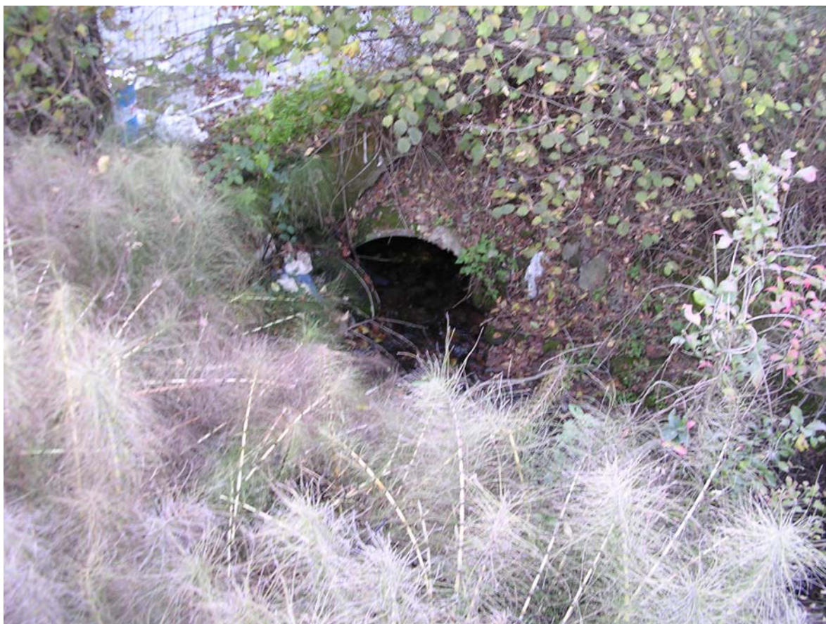
Foto 6 –inizio del tratto intubato della roggia irrigua derivata dal Torrente Norè
