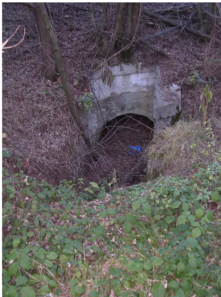
Foto 8 – immissione delle acque meteoriche raccolte dal rilevato FS nel Fosso Gola
